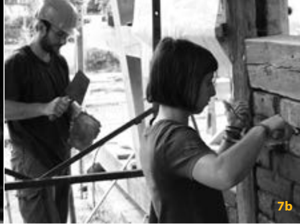
7a, b Beim Baucaamp 2009 wird ein Teil des Fachwerkes der „Alten Ausspanne“ saniert (Fotos: Elke Zielonka)
