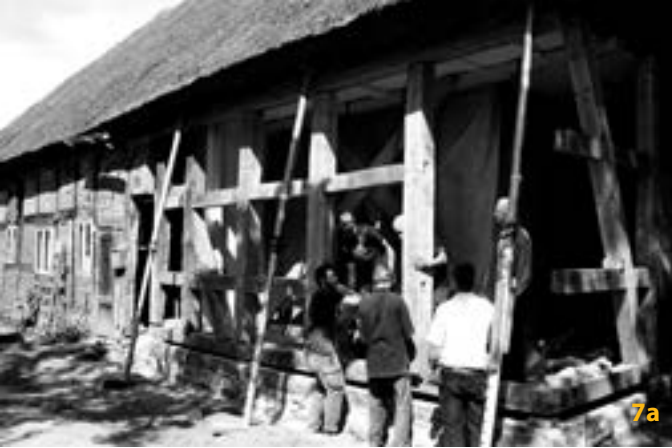
7a, b Beim Baucaamp 2009 wird ein Teil des Fachwerkes der „Alten Ausspanne“ saniert (Fotos: Elke Zielonka)
