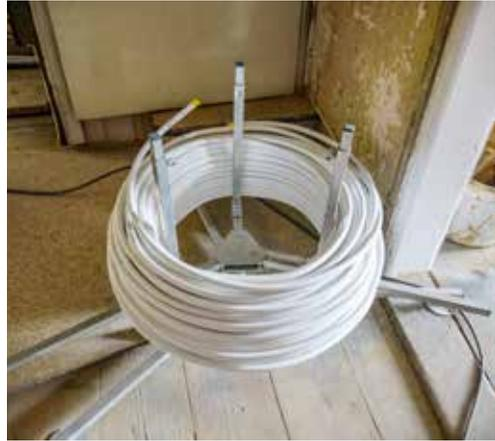
4 Spindel zum Abrollen des Heizrohrs
