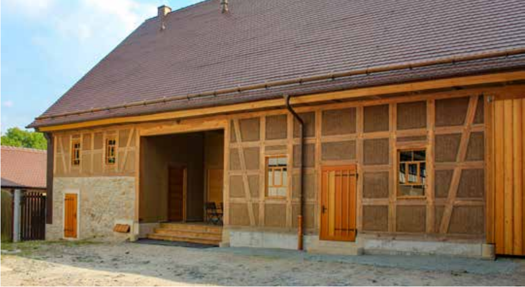
2 Hofseitige Ansicht der Sonnenscheune mit teilweise rekonstruiertem Fachwerk, 2019 (Foto: Hofgut Erler GbR)
