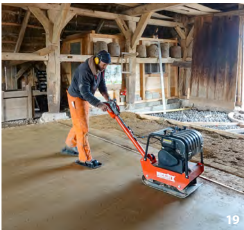
20 22. November 2019: Verteilung einer zweiten feinen Lehmschicht und anschließendes Glätten. Der Feinlehm ist trockener als der erdfeuchte Lehm für die Grundschrift.
