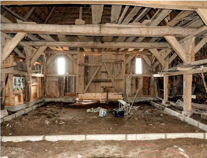
4 13. Oktober 2019: Das Fundament für die Begrenzung der Lehmfläche ist fertiggestellt. Der Boden ist noch ohne Füllung – zu sehen ist nur das anstehende Erdreich.
