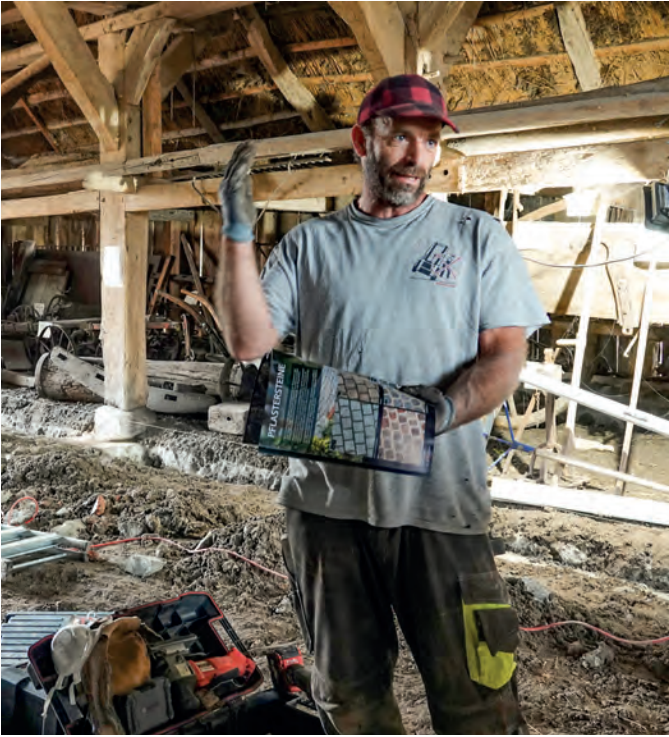
3 13. Oktober 2019: David Nicolini erklärt die Abfolge der Arbeiten, die für den Lehm Boden erforderlich sind.
