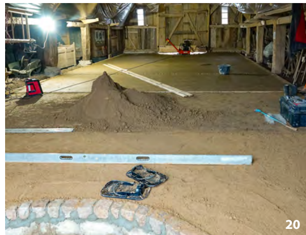
20 22. November 2019: Verteilung einer zweiten feinen Lehmschicht und anschließendes Glätten. Der Feinlehm ist trockener als der erdfeuchte Lehm für die Grundschrift.
