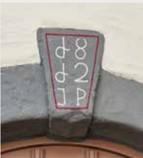
5 Schlussstein im Türgewand zum Gesindehaus
