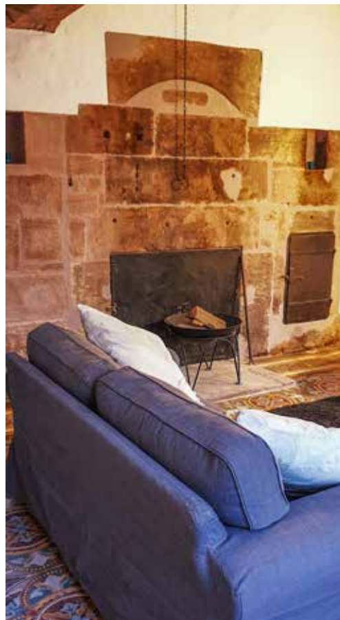
7 Alte Küche nach den Restaurierungsarbeiten, freigelegter Türsturz des Vorgängerbaus als Spolie in der Feuerwand (Foto: Familie Sente)
