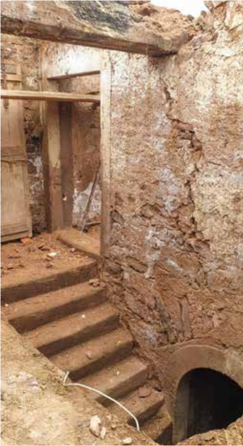
4 Gesindehaus vor der Restaurierung
