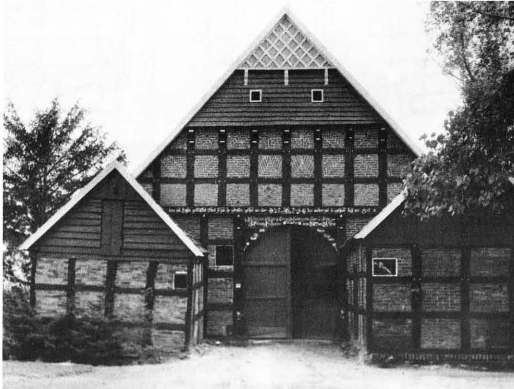
werkkonstruktion könnte man auch als Holzschutz sehen, da dadurch die Grundschwelle des Gebäudes weitgehend trocken bleibt. Im oberen Giebelndreieck wird auch deutlich, wie die senkrechte Verbretterung überfällt, so daß das Wasser abtropfen kann. Ganz wichtig ist, daß verbautes Holz, Schwellen, Ständer oder aber auch Verbretterungen so enden, daß ablaufendes Wasser nicht gebremst wird. Auf
