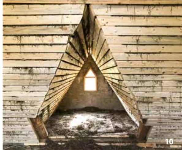
9, 10 *Dachschräge mit Seegrasdämmung*
