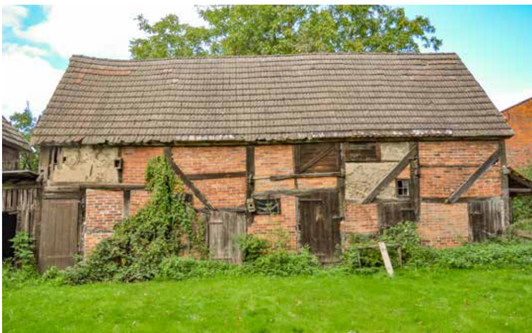
1 Der vor ca. zehn Jahren vorgefundene Zustand des Speichers mit Hartdach (Betonfalzziegel) und Ziegelausfachungen (Foto: G. Thalmann, 2013)
