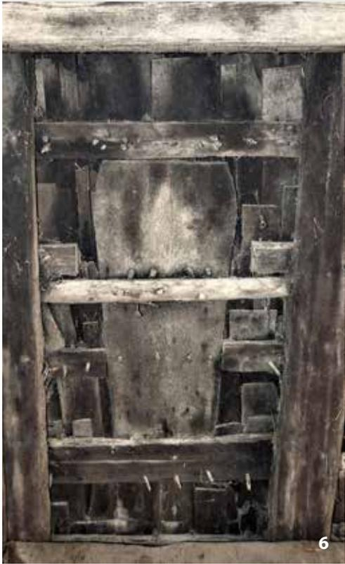
stemmen sie sich mit ihren von Walm zu Walm reichenden Aussteifungskonstruktionen einer Längsverschiebung des Daches entgegen, was dann auch den Einbau weiterer Winkelsicherungen im Unterbau weitgehend entbehrlich macht (Abb. 5).
