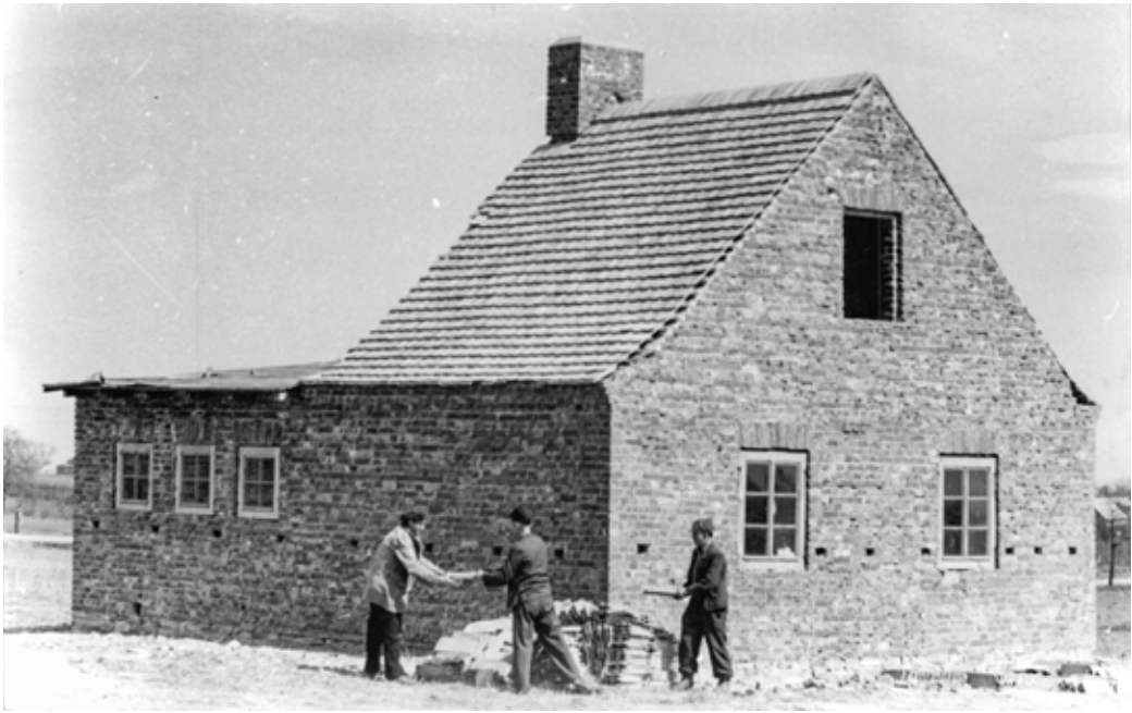
8 Erster Bauabschnitt eines Neubauernhauses vom Typ 50-L (Foto: Bundesarchiv, Bild 183-11221-0003, Biscan)
