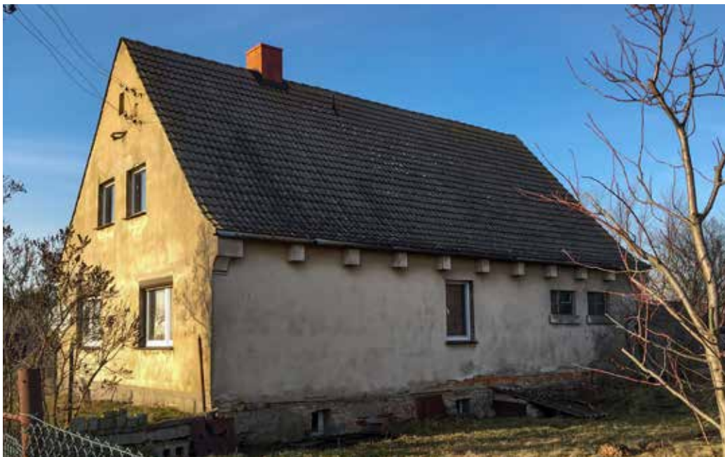
7 Neubauernhaus mit Deckenträgern aus Stahlbeton im Oderbruch, 2021 (Foto: Frauke Streubel)
