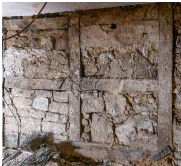
5 Bei der Sanierung kam diese Natursteinwand zum Vorschein (Foto: Bernd Demandt)
