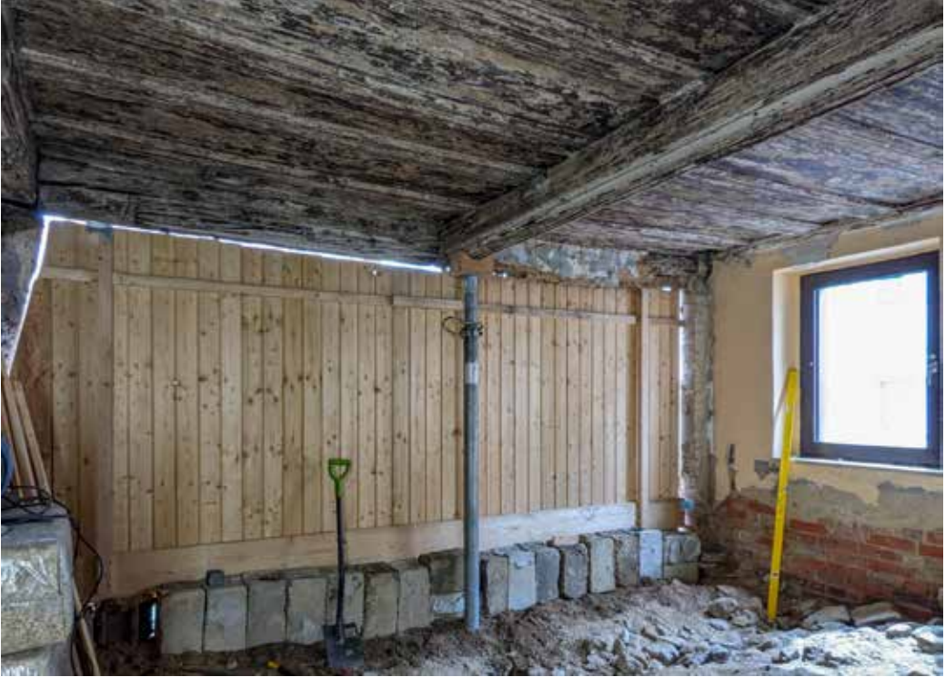
5 Bohlenstube: aktueller Zustand vor Sanierungsbeginn
