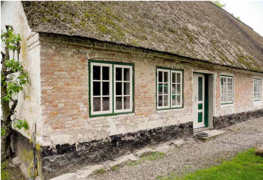
5 Ansicht der Hofseite nach Entfernen der alten Anstriche
