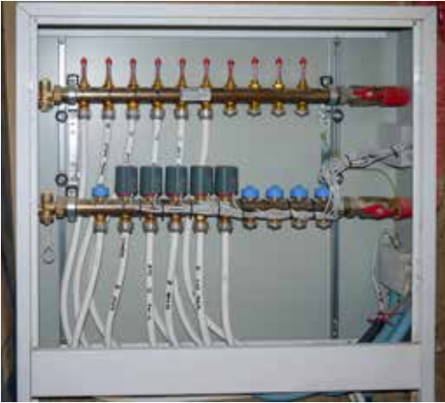
3 Heizkreisverteiler
