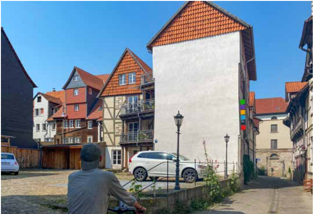
2 Das Fachwerkhhaus aus dem 18. Jahrhundert in der Speckstraße 7 nach der Sanierung: Es ist komplett vermietet und ein richtiges Schmuckstück geworden (Foto: Diana Wetzstein)
