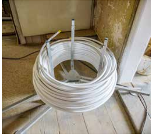
4 Spindel zum Abrollen des Heizrohrs
