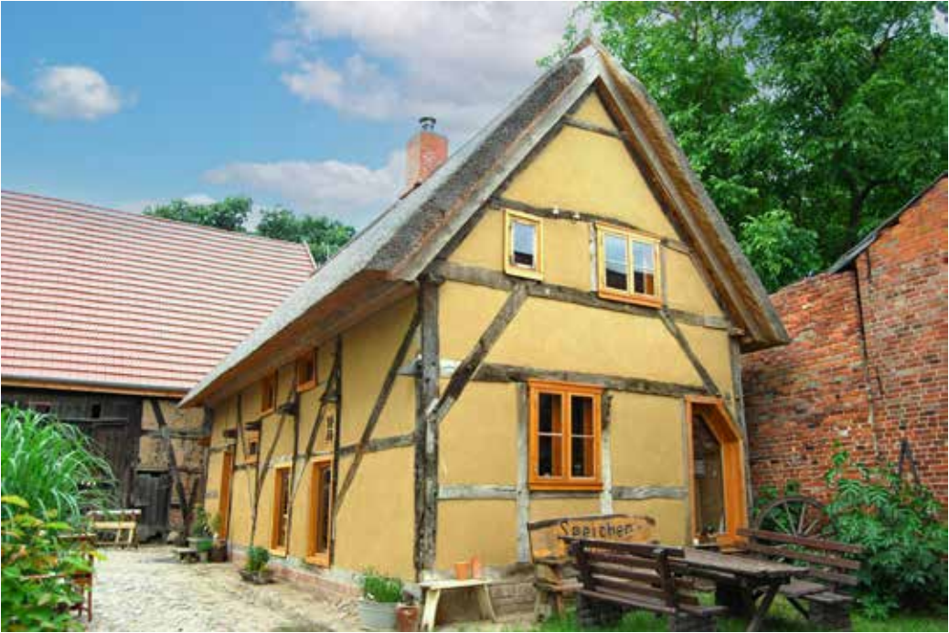
2 Der Garsedower Speicher nach seiner Sanierung (Foto: W. Beelitz, 2020)
