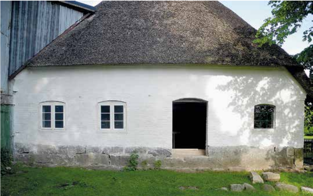
21 Ansicht der Westmauer nach erstem Anstrich mit Kalkschlämme. Auch hier deckt die Farbe bereits vollflächig. Dunklere Partien im Bereich der Fenster sind im nachträglichen Einsetzen und Verfugen derselben begründet
