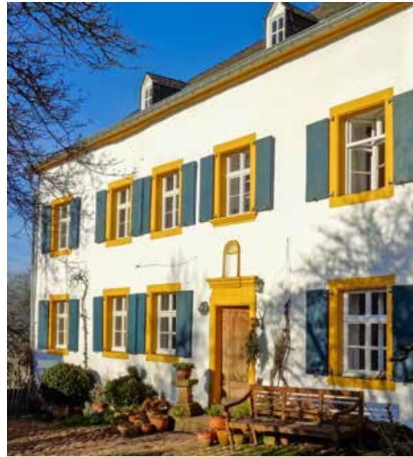
7 Himmeroder Hof in Scharbillig. 1273 als Grangie (Wirtschaftshof) der Zisterzienserabtei Himmerod erbaut; heute im Kern mittelalterlicher Winkelhof, ehemals Dreiseitanlage, spätestens 1374 an Hofleute verpachtet, nach Zerstörung Wiederaufbau „V 7 1733“; Modernisierung der Südfront um 1830/40 (Foto: Barbara Mikuda-Hüttel)
