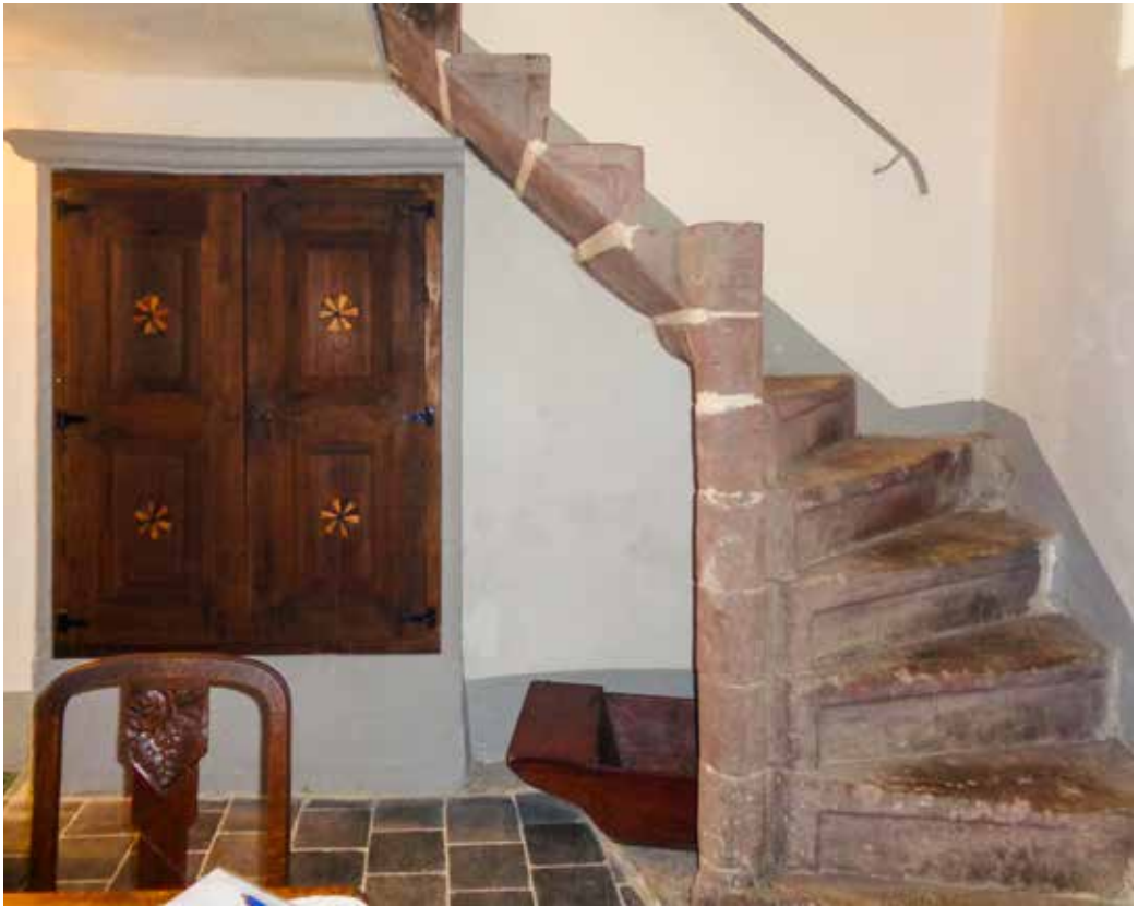
15 Spindeltreppe in Dudeldorf (Foto: Barbara Mikuda-Hüttel)
