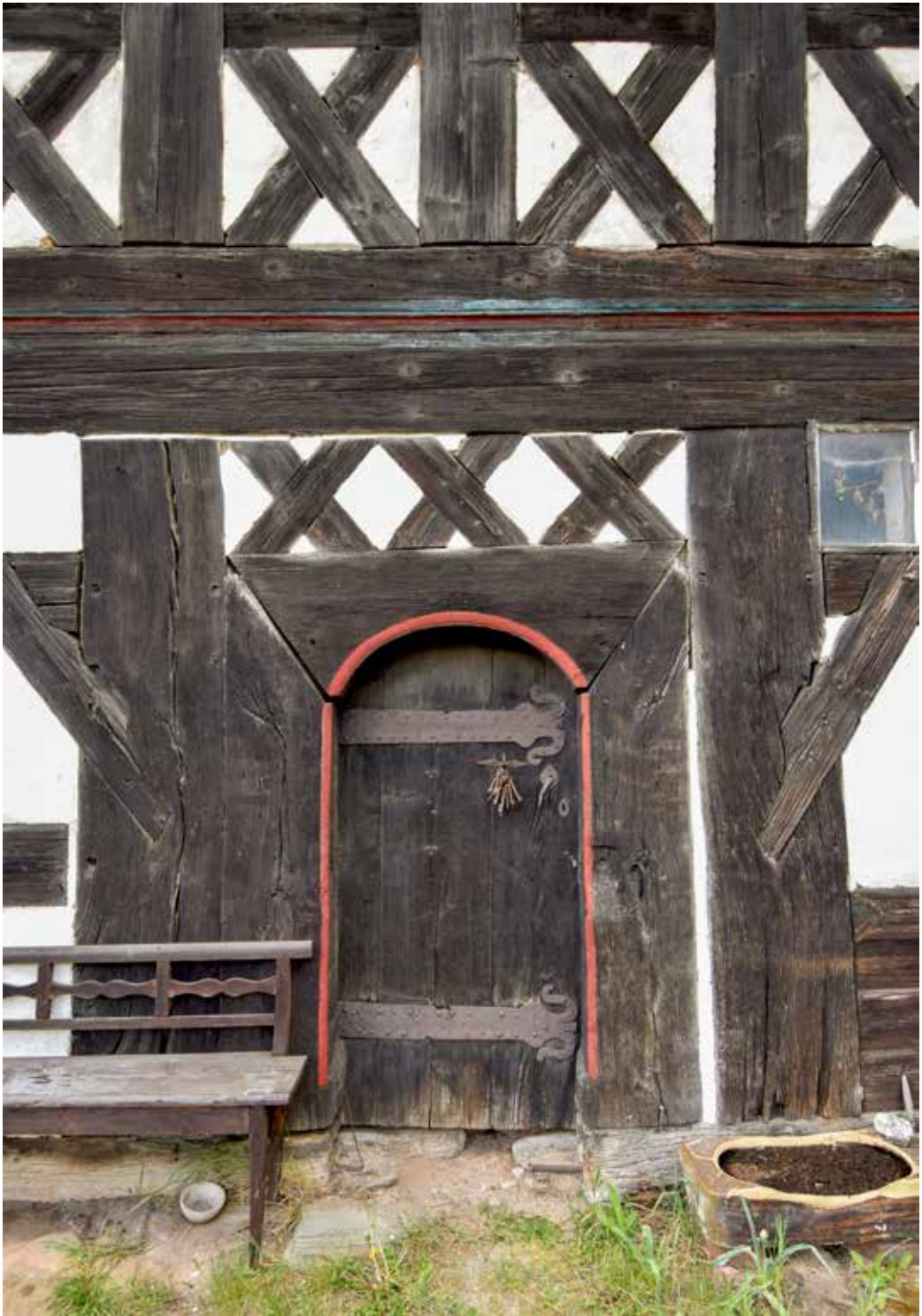
11 Jonaswalde Nr. 34. Fachwerk mit Andreaskreuzen und Türdetail (Foto: Karsten Stange)
