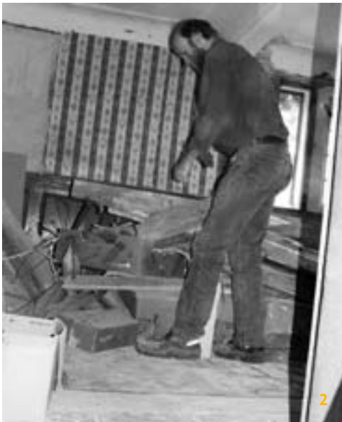
2 Harald Brode beim Sortieren und Aufräumen im Erdgeschoss
