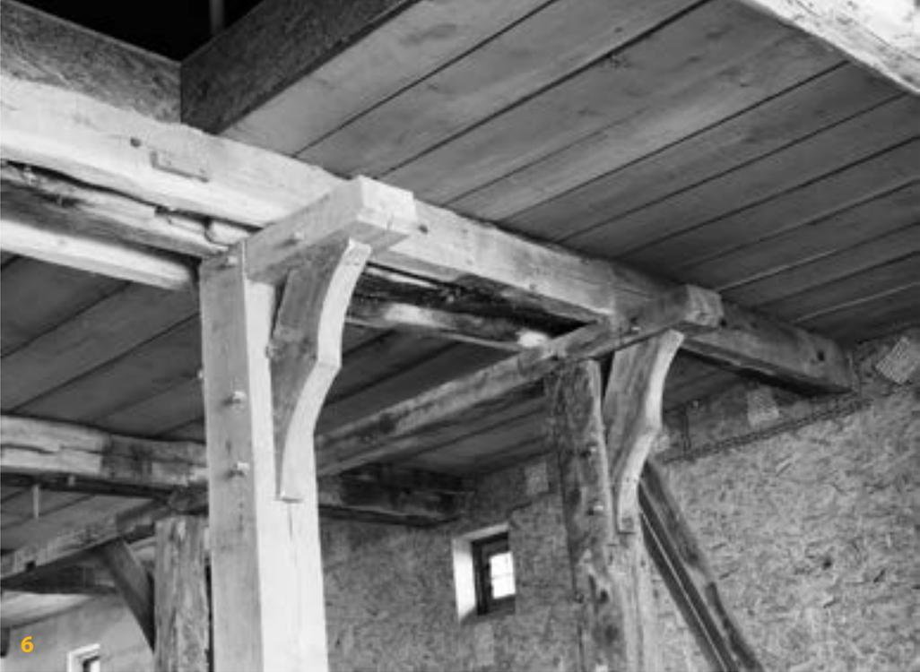
**6** *Geschichte trifft Moderne. Auf der Tenne zeigen die Ständer mit den Knaggen, dass hier der Kernbau von 1517 endete. Für ihn hatte Familie Grube nur einen Balken (1362 d) zweitverwendet, diesen aber prominent als Giebelbalken eingesetzt – hier das schwarze Mittelstück. Die Wände sind mit USB-Platten verkleidet, um eine zeitgemäße Wärmedämmung zu gewährleisten. (Foto: Bildarchiv Hof Grube)*
