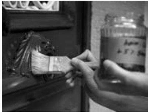
Zu kurze Trocknungszeiten des Öls bzw. zu frühe Folgeaufträge verzögern die zum Trocknen nötige Sauerstoffaufnahme des Voranstrichs. Dies kann zu wochenlangen Trockenzeiten führen. Trocknungsbeschleunigende Maßnahmen wie „Fönen“, in die Sonne stellen oder die Beimischung von Sikkativen beeinträchtigen die Anstrichqualität. Die Oberfläche bildet eine Haut, und es können Blasen und Risse entstehen.
