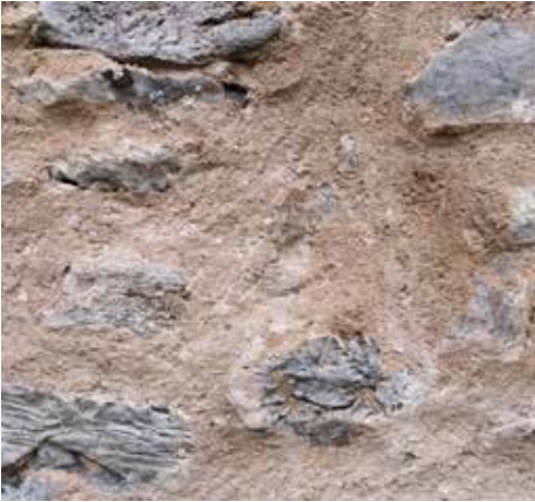
4 Detailaufnahme der neu verfugten Mauer mit Kalkspatzen (Foto: Dengel-Bau)
