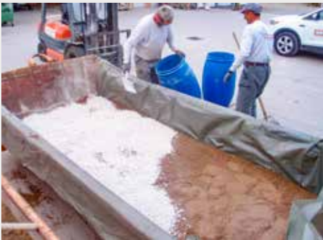
5 Auf ein ca. 20 cm dickes Sandbett kommt eine Schicht Stückkalk
