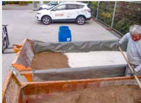
6 Der Kalk wird mit Sand abgedeckt (Fotos: Dengel-Bau)
