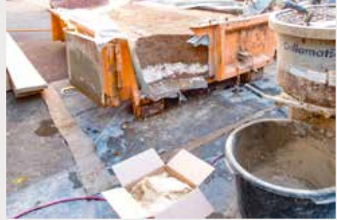
8 Fertiger Mörtel: Der Mörtel wird von vorn abgestochen (Fotos: Dengel-Bau)
