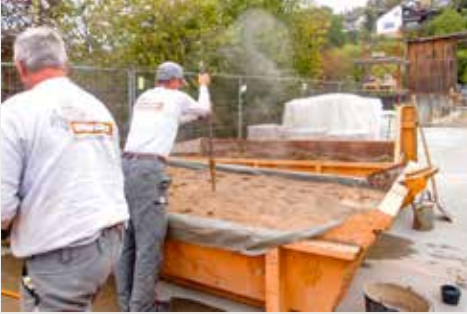
7 Hitzeentwicklung beim Löschvorgang
