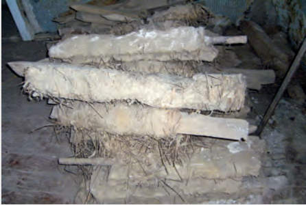
Wellerhölzer (Quelle: Chron-Paul, Lehmstaken (Knüppel, Stroh und Lehm) ausgebaut im Schloss Quilow by CC BY-SA 4.0, Wikipedia)
