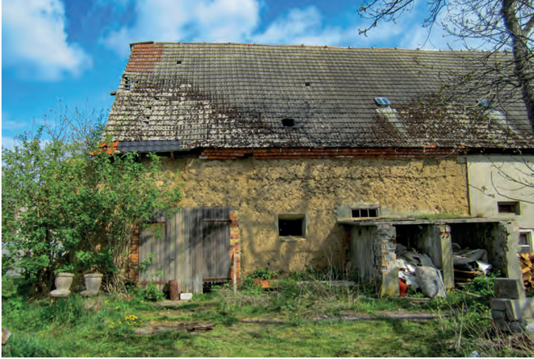
2 Brunnenstraße 45: geziegelter Übergang zwischen Mauer und Dach; Ziegeleinfassung des Tores
