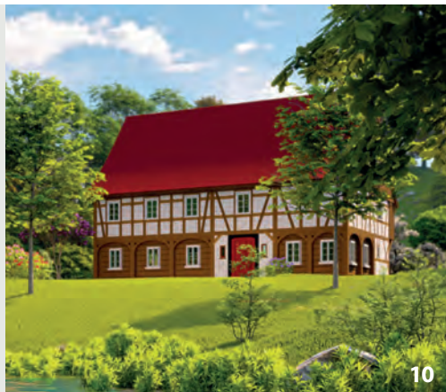
9 Umgebände in Mischbauweise mit Fachwerk im Obergeschoss (Quelle: IZU)
