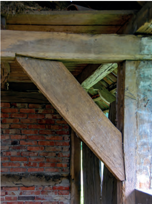
11 Kopfband zwischen Ständer und Balken beim Scheunengebäude in Goldenstedt (Fotos: Dörfler)
