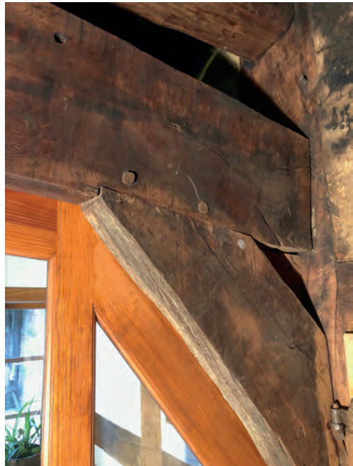
12 Eingezapftes Kopfband „mit Versatz“ am Unterschlag in Hesedorf b. Gyhum (Foto: Dörfler)
