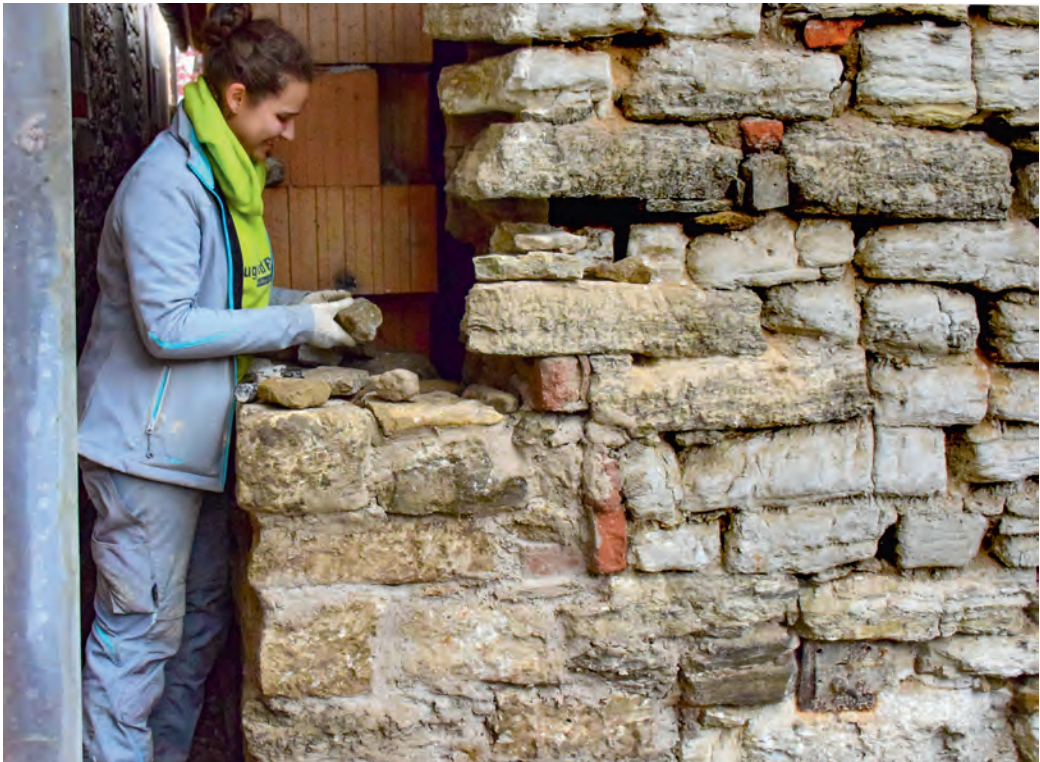
10 Die fehlende Mauerecke wird mit Bruchsteinen aus einem anderen Hausabbruch aufgemauert. (Foto: Jugendbauhütte Regensburg)
