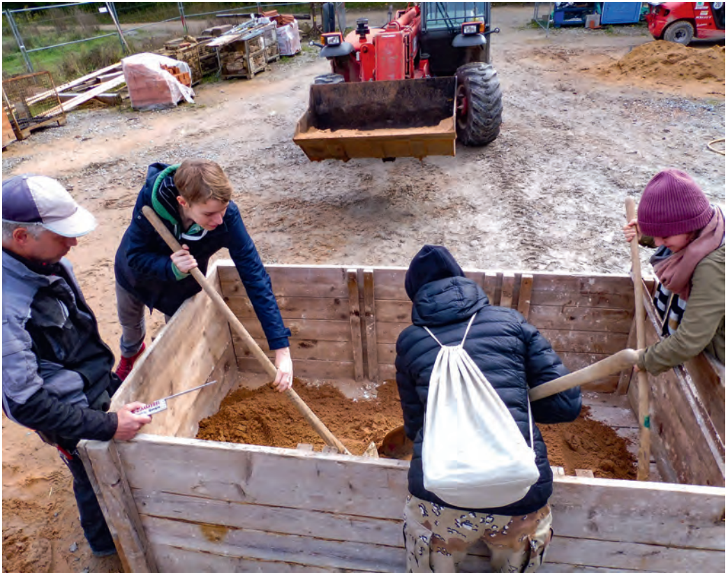
9 Besuch im Fränkischen Freilandmuseum in Bad Windsheim: Freiwillige füllen unter Anleitung eine Kiste mit Sand und gebrannten Kalksteinen an, um trocken gelöschten Kalkmörtel herzustellen. (Foto: IG Bauwerk- halt)
