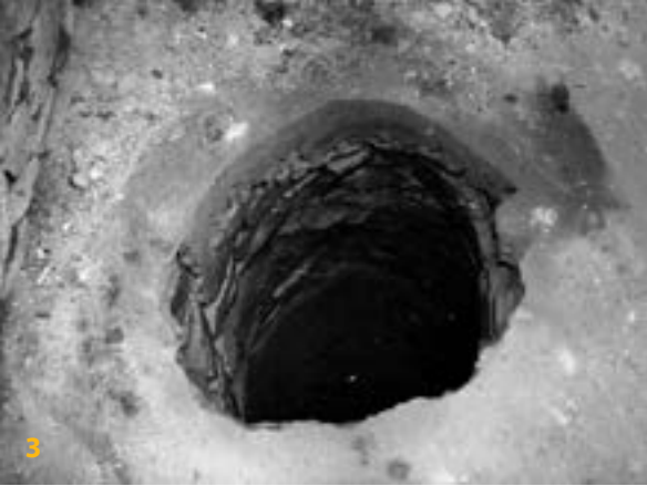
3 Überwölbter Wasserauslauf mit Plattenboden
