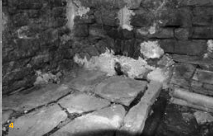
4 Gemauerter Brunnenschacht (Fotos: Kristin Dohmen, LVR-ADR 2013)
