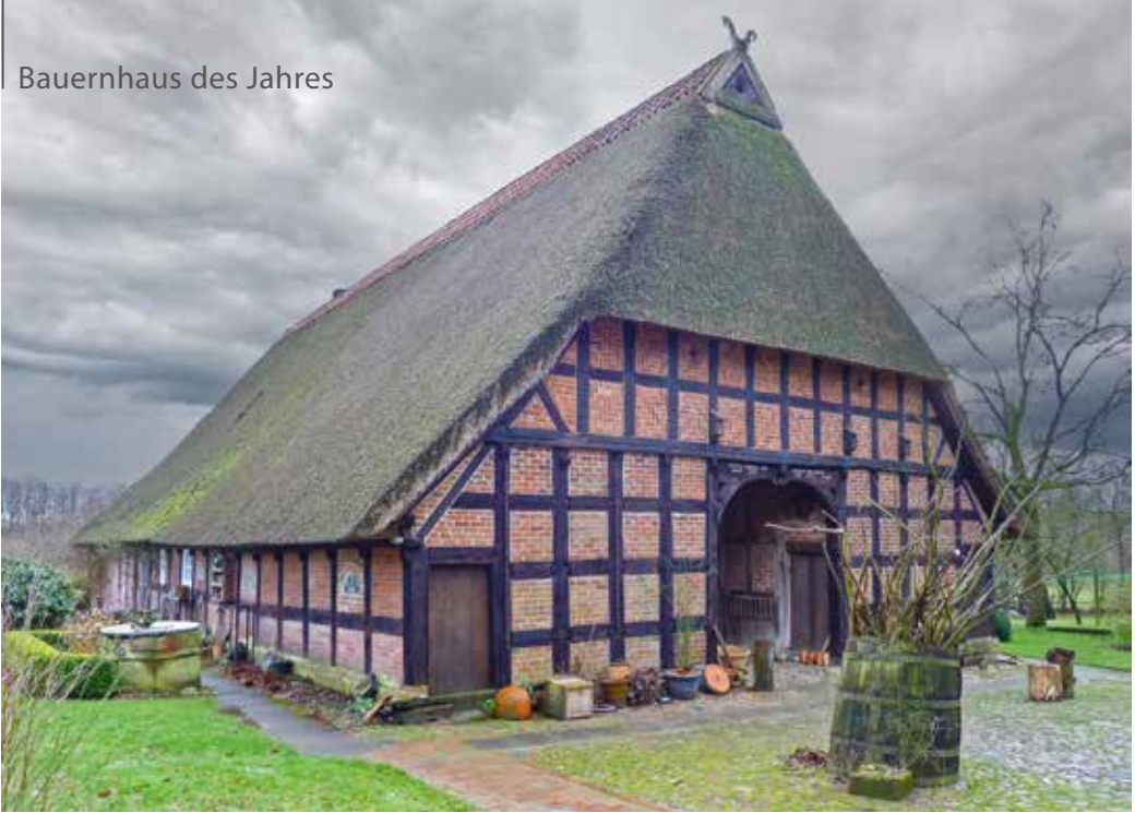
1 Niederdeutsches Hallenhaus von 1773 (i) in Syke-Henstedt Nr. 5; Größe: 13 x 30 m (Foto: Heinz Riepshoff)
