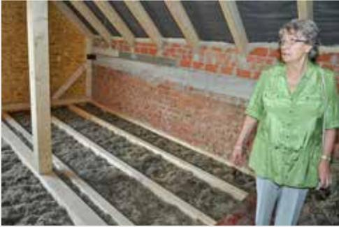
3 Hanffasern für die Dachgeschoss-Bodendämmung. Damit hat man Kälte- und Hitzeschutz
