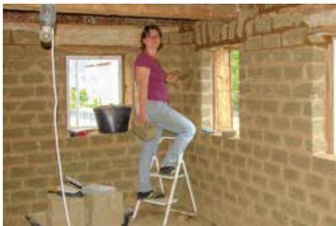
3 Um die Wärmedämmung zu verbessern, wurde vor die alte Wand eine Lehmziegelwand gesetzt
