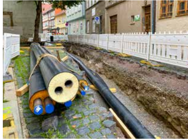
7 Rohre für das Nahwärmenetz (Foto: Diana Wetzstein)
