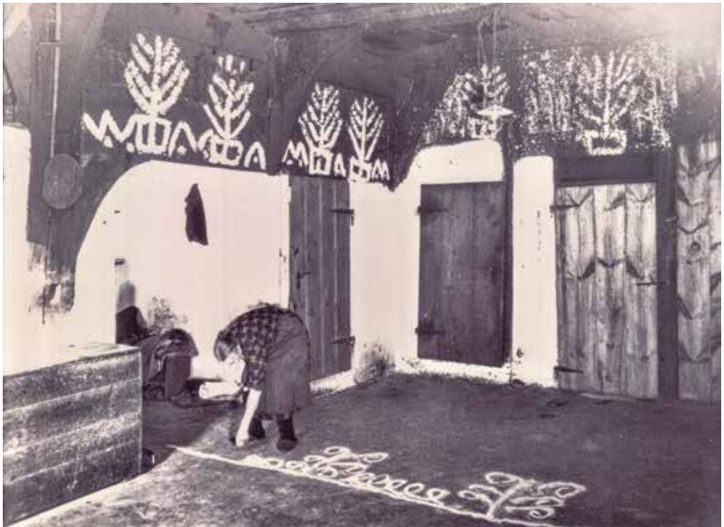
1 Die Bewohnerin streut ein Sandmuster auf den Dielenboden. Auf den Luchtbalken und der ehemaligen Herdwand sind Tannenbaumzeichnungen aus Kalkfarbe. (Quelle: Heinz Riepshoff, Bauernhaus-Archiv, Syke)
