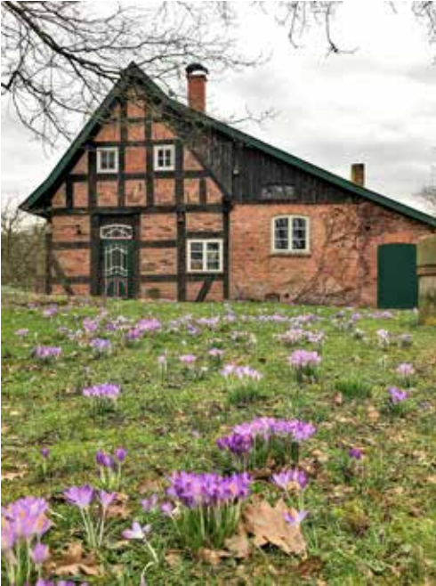
5 Eines der erhaltenen Nebengebäude mit einer neuen Nutzung als Wohngebäude
