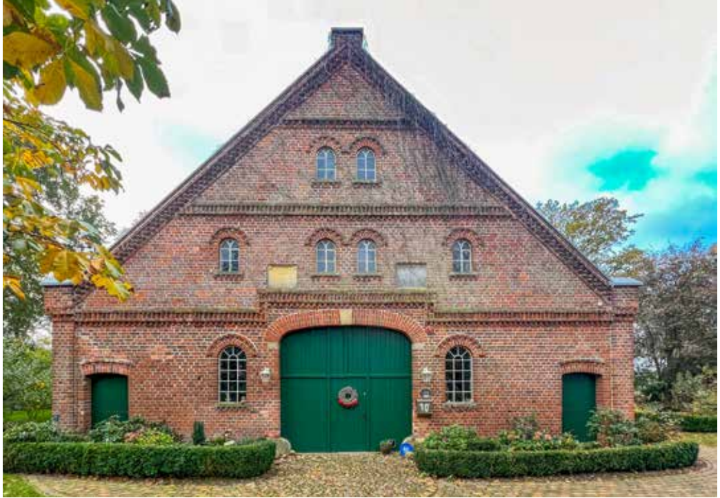
20 Spraken bei Schwarme (Lkr. Diepholz), Hallenhaus mit Backsteinaußenwänden von 1880 (Foto: Kunze 2022)
