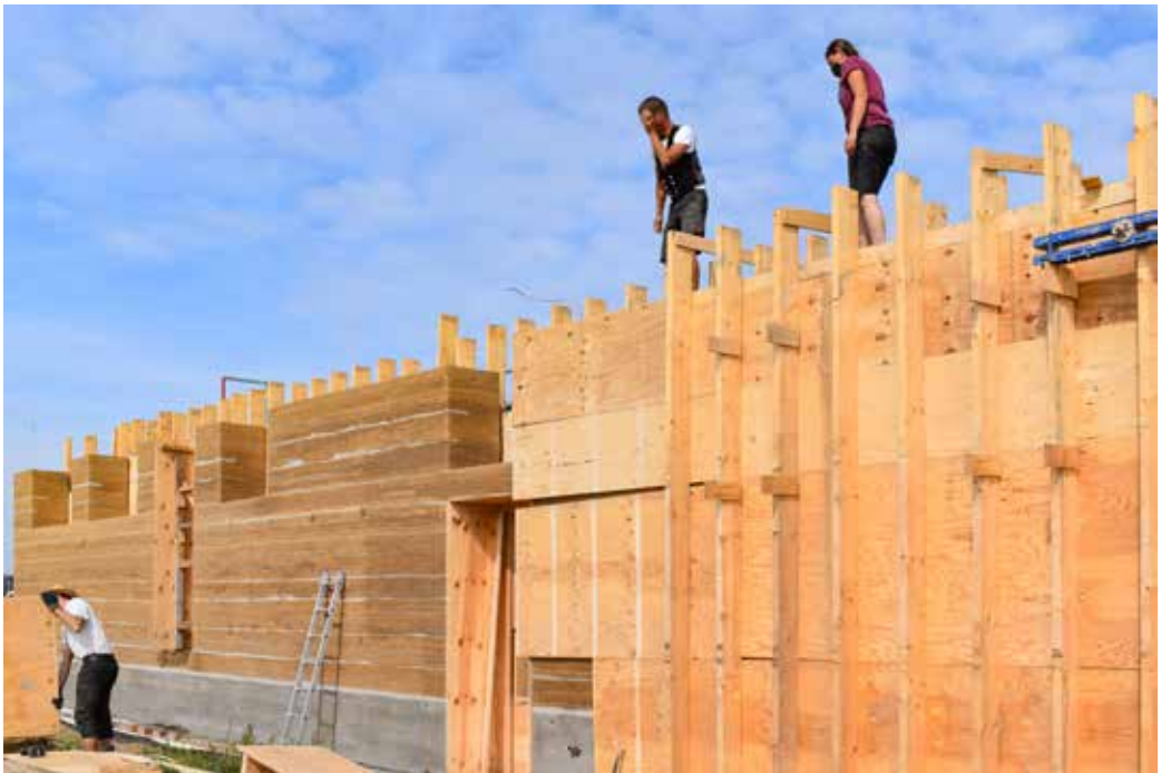
7 Um Bauherren von massiven Lehmkonstruktionen zu überzeugen, braucht es mehr Vorzeigeobjekte. Aktuell entsteht am Ringheiligtum Pömmelte (Salzlandkreis) ein Stampflehm-Neubau, der als Besucherzentrum dienen wird. Es handelt sich nach über 60 Jahren um den ersten öffentlichen Massivlehm-Bau in Sachsen-Anhalt. (Foto: GOLEHM, 2021)
