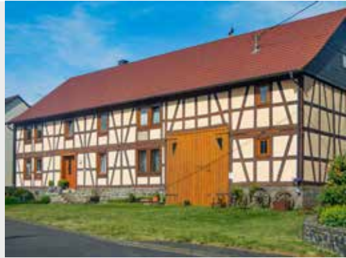
14 Umgenutztes Einhaus in Meiches mit wiedereingesetztem Fachwerk im Stallbereich (Foto: J. Michael Ruhl)
