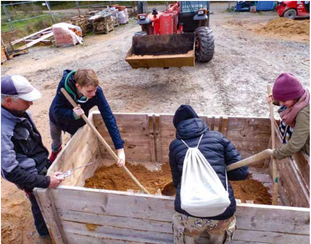
9 Besuch im Fränkischen Freilandmuseum in Bad Windsheim: Freiwillige füllen unter Anleitung eine Kiste mit Sand und gebrannten Kalksteinen an, um trocken gelöschten Kalkmörtel herzustellen. (Foto: IG Bauwerk-erhalt)
