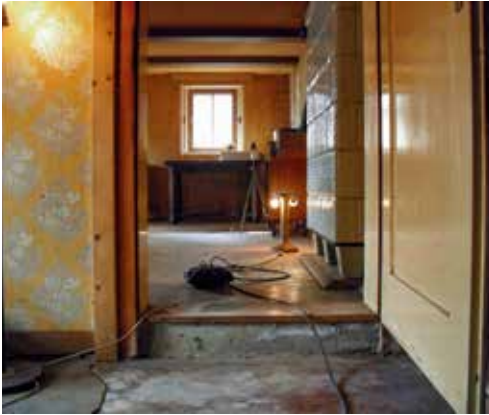
12 Der Blick vom Eingangsbereich in die Blockstube
