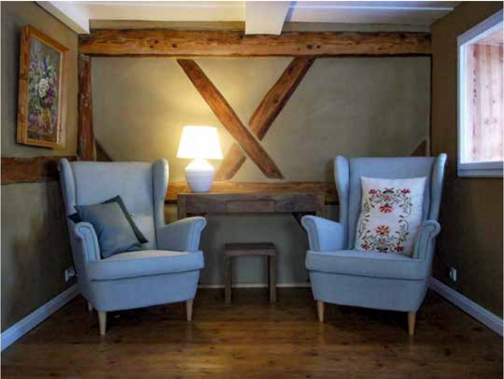
14 Das wiederentdeckte Andreaskreuz in der frisch verputzten Lehmwand
