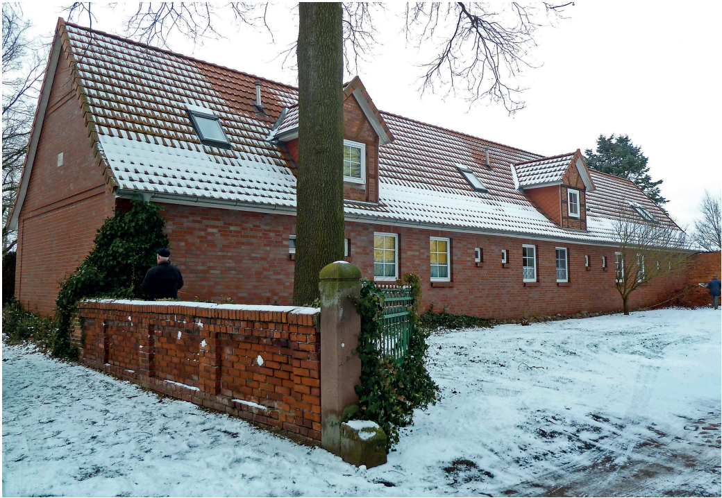
11 Stedorf Nr. 21, Gem. Dörverden (siehe auch Titelbild): Der 1897 errichtete Schweinestall (8 x 33 m) wurde schon vor Jahren mit Wohnungen ausgebaut und wird wohl auch in einigen Jahrzehnten noch den Hofplatz prägen – ein in der Gemeinde seltenes Beispiel.
