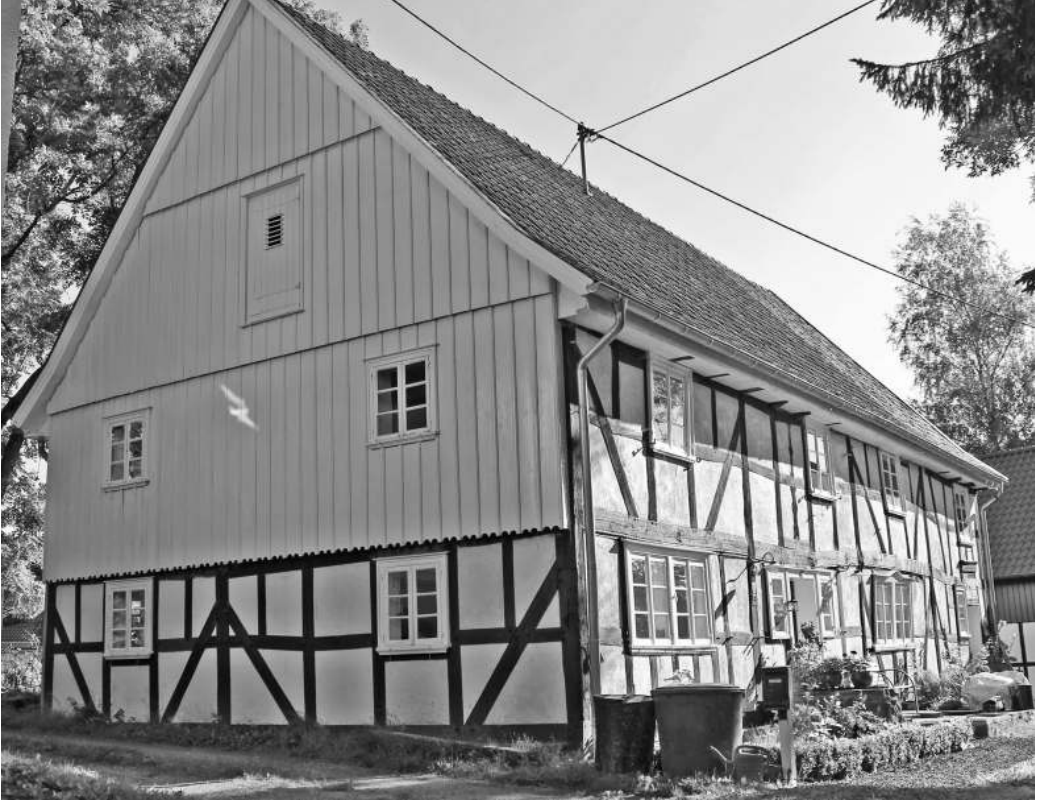
4 Das Fachwerkhaus in Nümbrecht nach der Instandsetzung (Foto: Michael Hanisch)
