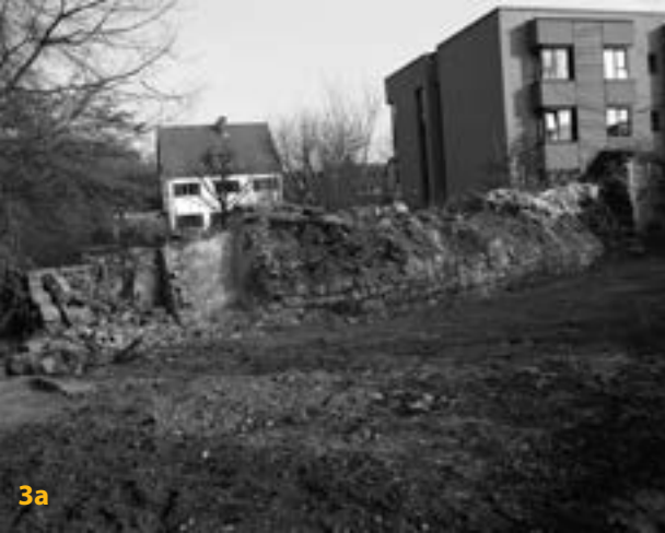
3a, b Das auf ca. 25 m stark beschädigte und um ca. 1,5 m an Höhe abgetragene Teilstück der Stadtmauer.
