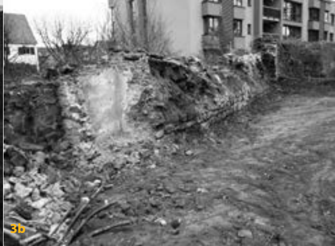
3a, b Das auf ca. 25 m stark beschädigte und um ca. 1,5 m an Höhe abgetragene Teilstück der Stadtmauer.
