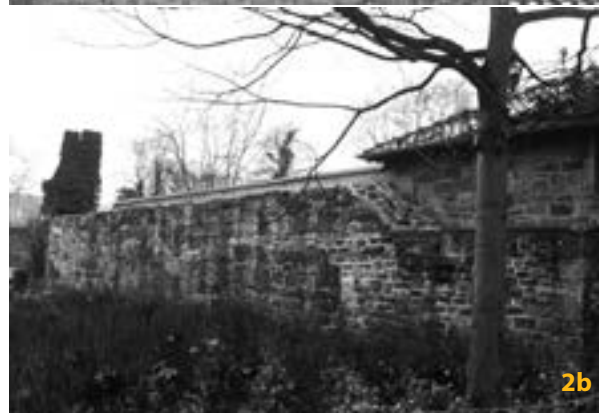
2a, b Verlauf von zwei Partien der Stadtmauer vor dem baulichen Eingriff
