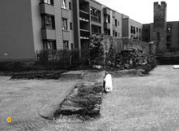
Der bis auf einen Sockel abgetragene Abschnitt der Stadtmauer, der in die geplante Wohnanlage integriert werden soll.
