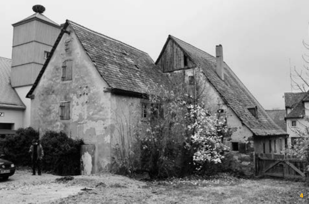
4 Rückseite des Hauses mit Anbau. Diverse Schäden im Dach wurden vor dem Abriss noch repariert.
