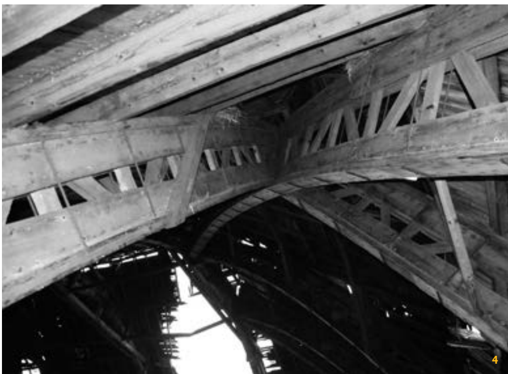
3, 4 Die parabelförmigen Binder verleihen dem Inneren der Suckower Halle einen geradezu sakralen Anschein. (Fotos: Ch. Langner)
