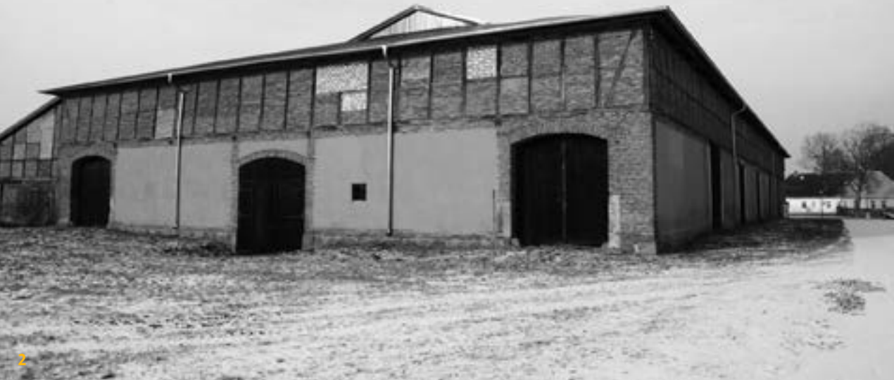
2 In Böhlendorf befindet sich eine der größten Guttscheunen in Mecklenburg-Vorpommern. Das Gebäude ist genutzt und in einem sehr guten Zustand. (Foto: Ch. Langner)
