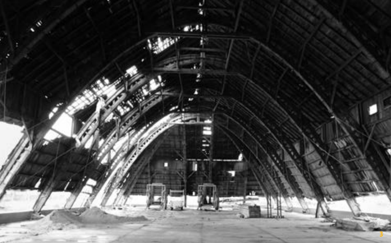
3, 4 Die parabelförmigen Binder verleihen dem Inneren der Suckower Halle einen geradezu sakralen Anschein. (Fotos: Ch. Langner)
