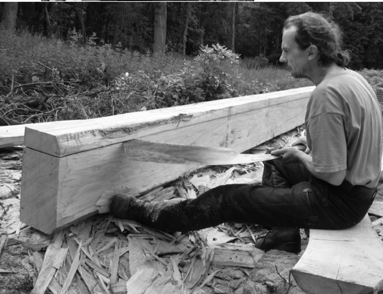
4 Mit einer japanischen Säge, der Maebiki Oga, werden Schwellen und Pfetten gesägt. (Foto: A. Weller)
