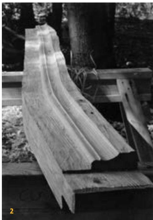
2 Profil in einem gebogenen Balken (Foto: A. Weller)
