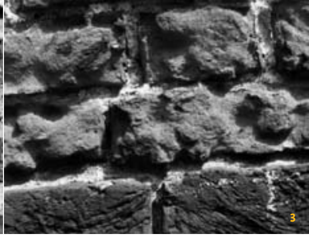
2 Verwitterungsformen: Kavernenbildung (Alte Kanzlei, Tangermünde) 3 Reliefbildung (Kampischer Hof, Stralsund)
