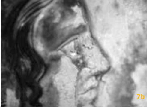
7a,b Matrixablösung durch Gipskristallwachstum: Terrakotta-Verwitterung mit Krusten und Abschalung (Schweriner Schloss)
