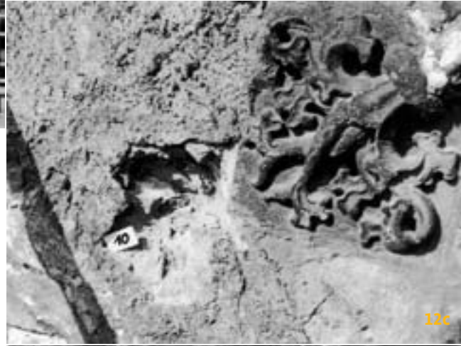
12 a, b, c und d Terrakotta-Gefügezerstörung am Rathaus Zeitz
