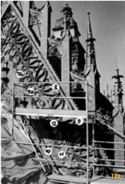
12 a, b, c und d Terrakotta-Gefügezerstörung am Rathaus Zeitz
