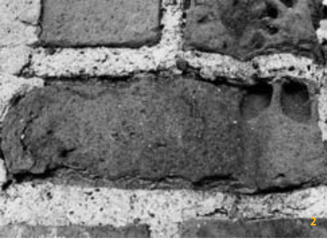
2 Verwitterungsformen: Kavernenbildung (Alte Kanzlei, Tangermünde) 3 Reliefbildung (Kampischer Hof, Stralsund)
