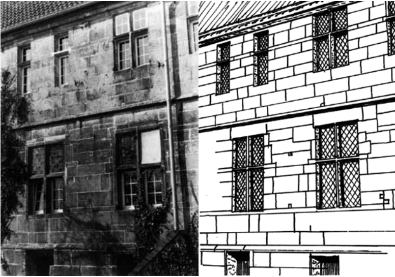
Abb. 16: Kloster Frenswegen bei Nordhorn, Südseite des Südflügels. Heutige Gestalt der Kreuzpostfenster (um 1740, ursprünglich nur bleiverglast) sowie Rekonstruktion der ursprünglichen Form von etwa 1480.
