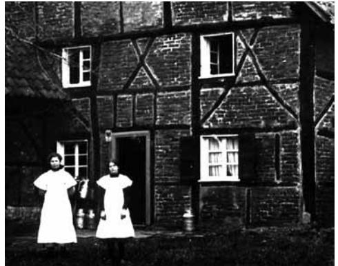
Abb. 8: Gladbeck, Haus Kuhlmann: Auch hier sind über der Tür deutlich die Klappstiele der ehemaligen Bleifenster zu sehen.
